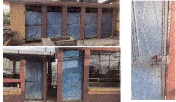
Foto 2: Mantenimiento a estructura (lijado y aplicación de pintura a puertas de aulas y baños ) y sustitución de una chapa.
