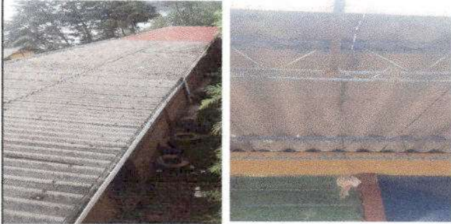
Foto 1: Módulo 2, Sustitución de lámina por lámina troquelada, sustitución de capote y sustitución de elementos de fijación.
