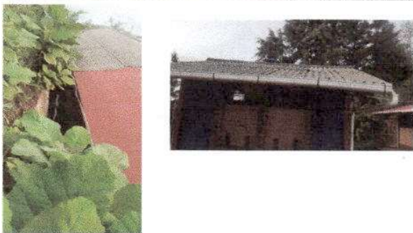
Foto 5: Sustitución de canal de pvc
