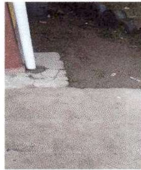
Foto 4: Reparación de piso de torta de concreto
